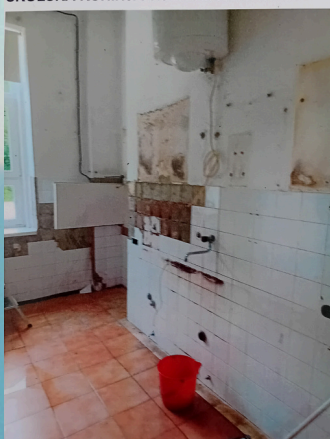
ŠKOLSKA KUHINJA TIJEKOM RENOVACIJE
